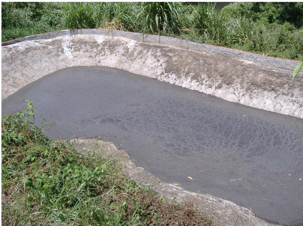
Figura 4 – Exemplo de um depósito de dejetos líquidos de suínos com revestimento em argamassa.
