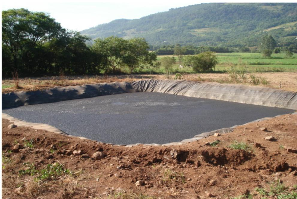
Figura 3 – Exemplo de um depósito de dejetos líquidos de suínos com revestimento em geomanta.
