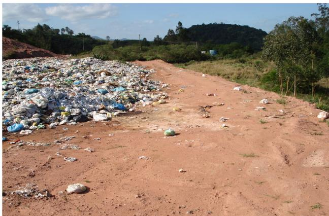
**Figura 06** – Um aterro contém os resíduos, mas não há isolamento para conter o percolado
