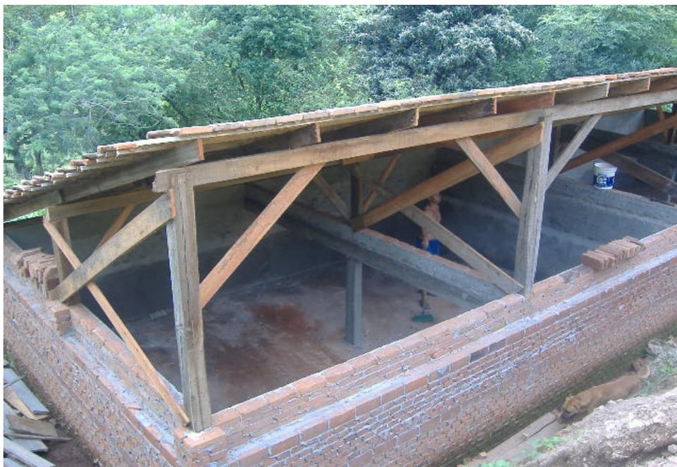
Figura 2 – Exemplo de um depósito de dejetos líquidos de suínos com revestimento em alvenaria.
